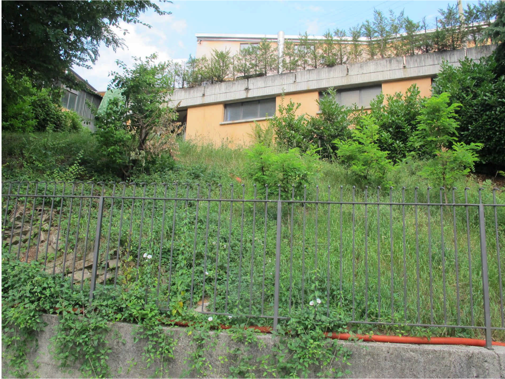
Foto 2: ripresa fotografica della aerea di intervento da valle
